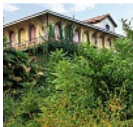
Uno degli edifici nel parco dell'ex Ospedale Militare.
